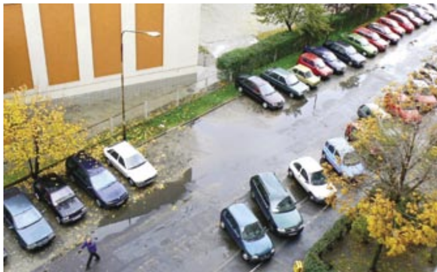
Parking przy ul. Bobrzej będzie wyremontowany
